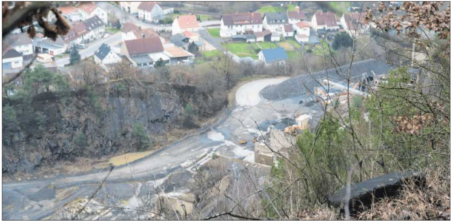
Eine Deponie für gering belasteten Erdaushub und mineralische Abfälle soll im ehemaligen Steinbruch entstehen.
